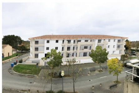
Après les travaux
